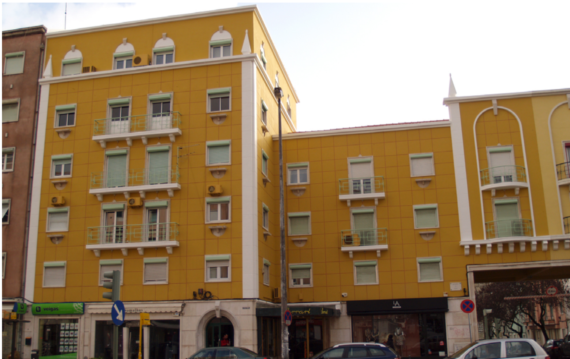
Apresentação Opus Signigum Reparationem, Lda.
